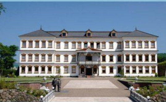
小坂鉱山事務所
